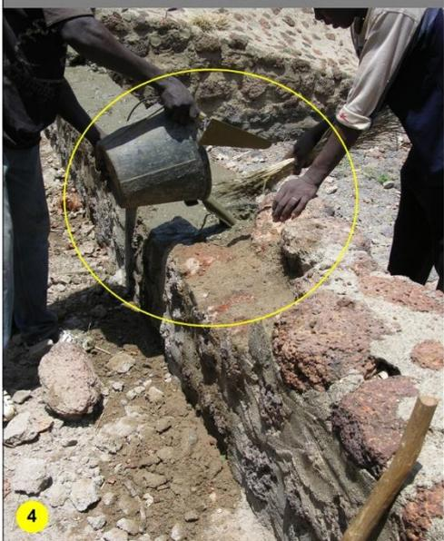
Maçonnerie de moellons d'une nouvelle arasée
