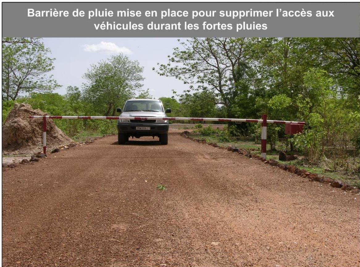
Pendant les périodes de fortes pluies il est fortement recommandé de mettre en place un système permettant de fermer l'accès aux véhicules. La méthode que nous préconisons à cet effet est la mise en place de barrière de pluie qui devra être géré par les CVP de chaque village concerné.
