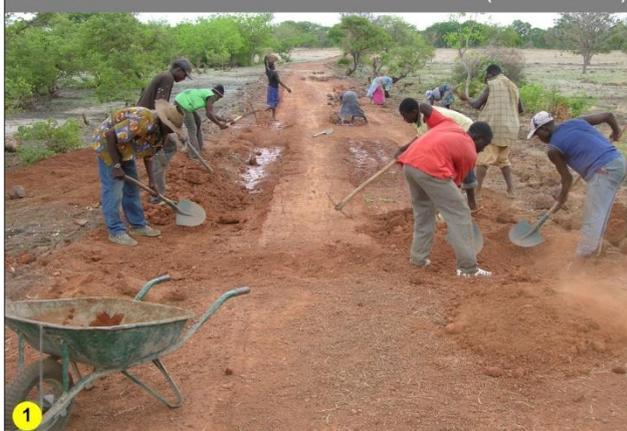
Reconstruction d'une nouvelle couche d'enrochement
