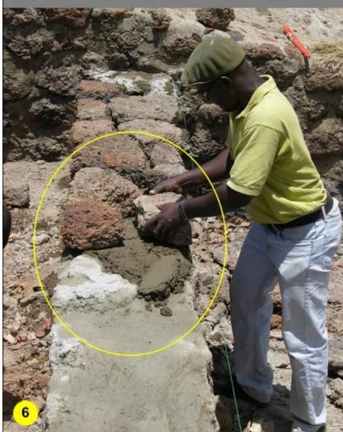
Jointoiment des moellons au mortier de ciment
