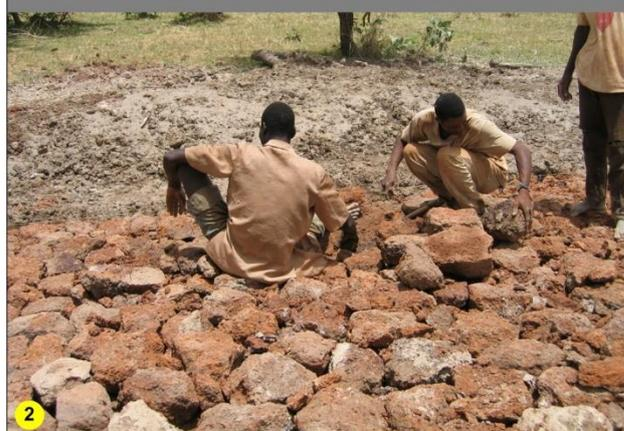
Rechargement sur l'enrochement d'une couche de latérite de 5 à 10 cm
